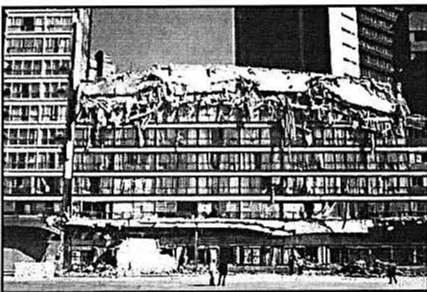
Fig. 2(a): Flat slab Hotel (Mexico 1985)
